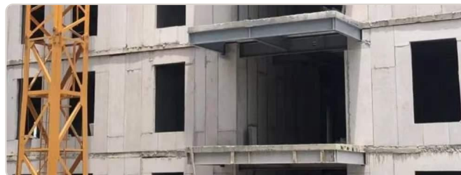
Cerramiento exterior en edificio en construcción
