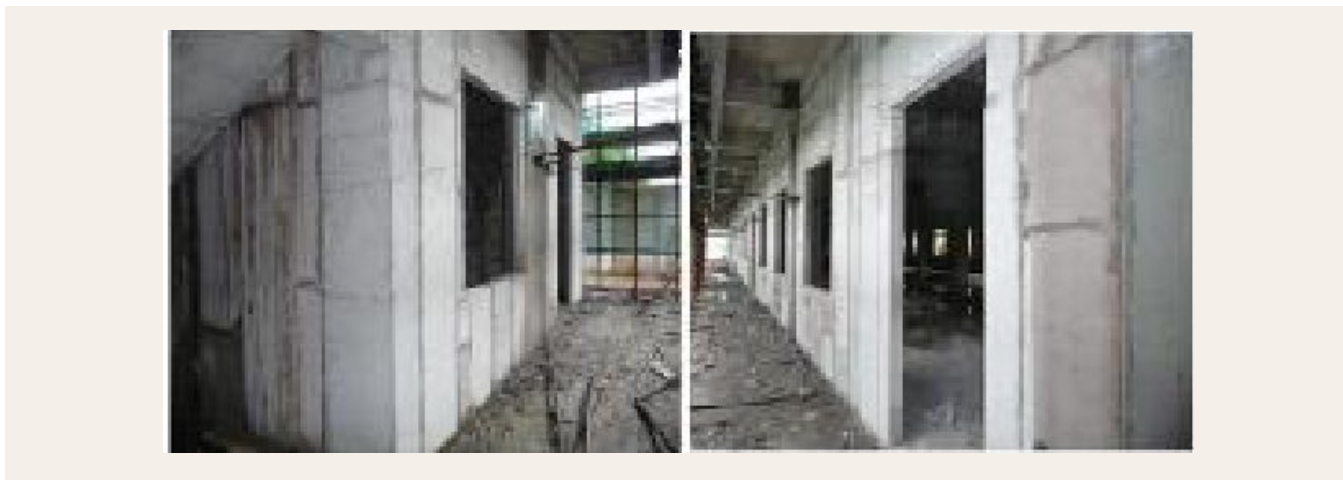
Tabiquería interior instalada — acabado visto del panel antes de revestir.
