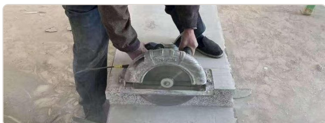
Corte del panel en obra con herramienta específica
