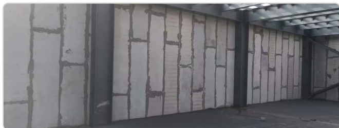
Particiones interiores en nave industrial
