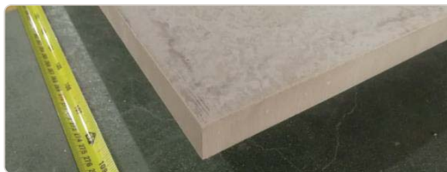
Detalle de canto — espesor medido de la muestra ensayada (~20mm)
