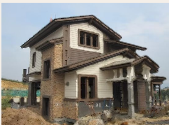
Vivienda con revestimiento de fachada SOLITH SHIELD SIDING combinado con piedra natural, obra en ejecución.
